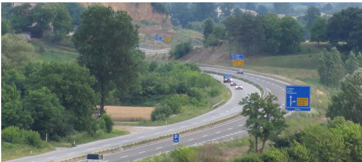
autoput BATOČINA – KRAGUJEVAC – aerodrom Morava / u izgradnji/
